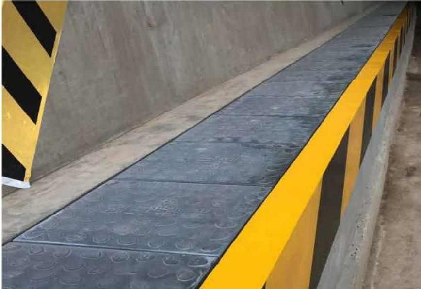
图F.18 超高性能混凝土隧道电缆槽盖板应用
